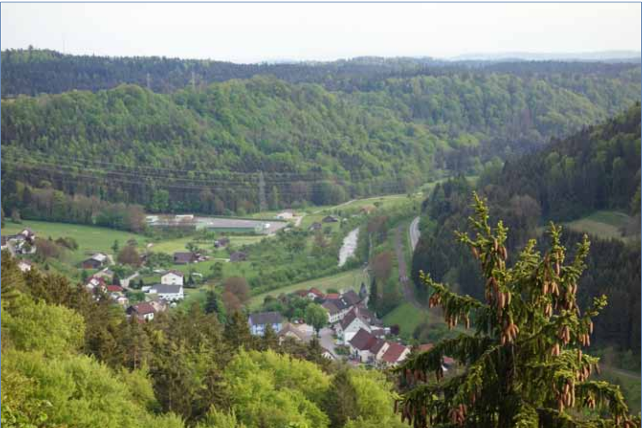
Ansicht Grimmelshofens von der Hochebene aus, Standort Flüheblick, Mai 2019. Die Lagerhalle der Spedition Heine als Überbleibsel des Industriegebiets ist gut erkennbar. Ebenso der noch parallele Dreiklang aus Wutachlauf, Eisenbahn und B 314.
