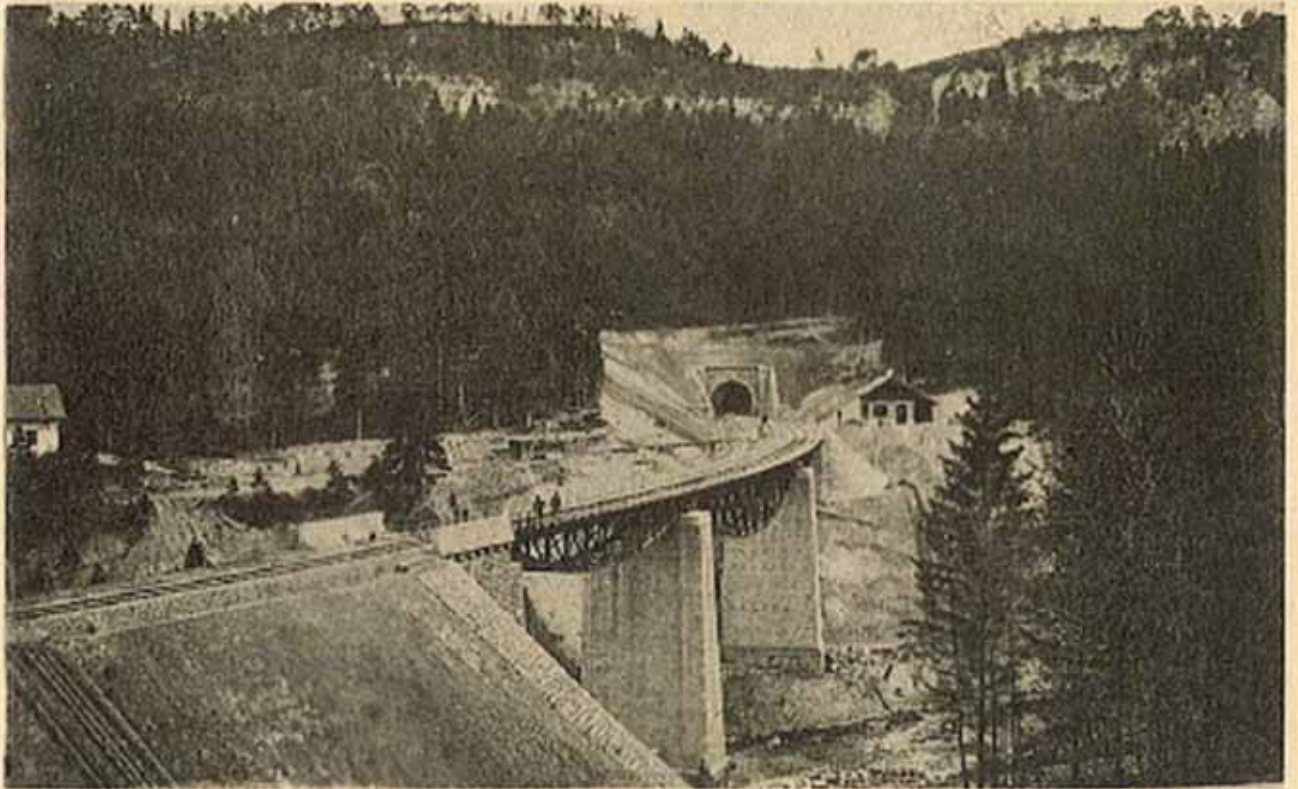
Viaduct über die Wutach.
