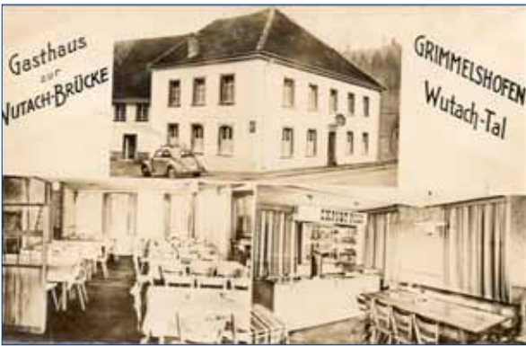
Postkarte des Gasthauses zur Wutachbrücke 1958, vermutlich nach dem Umbau von Anton Stich
