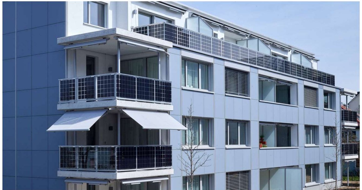
Balkonsolargeländer Quelle: www.anytech-solar.ch
